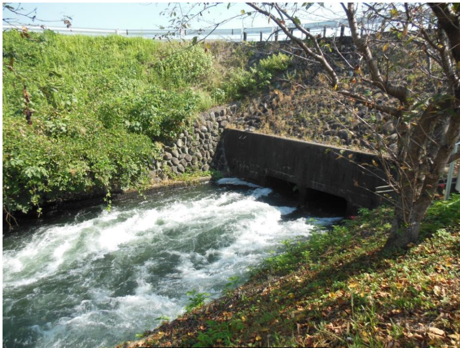
写真⑫ 取水ゲートの下流
