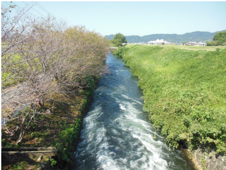
写真⑥ 取水ゲートの下流
