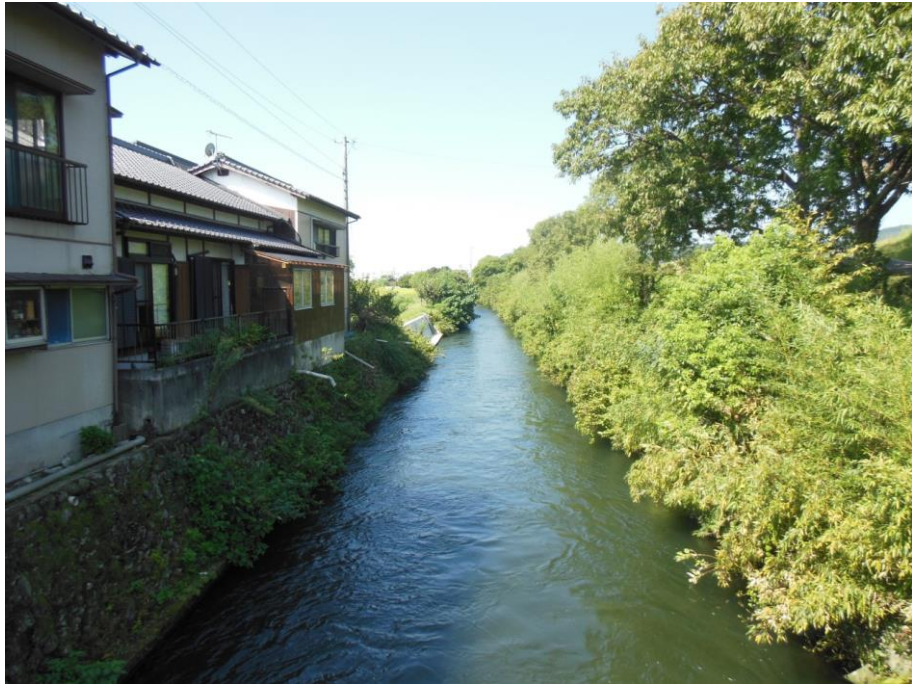
写真⑬ 取水ゲートの下流
