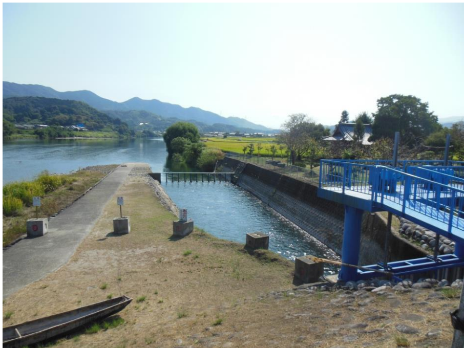
写真④ 大石用水路の取水口
