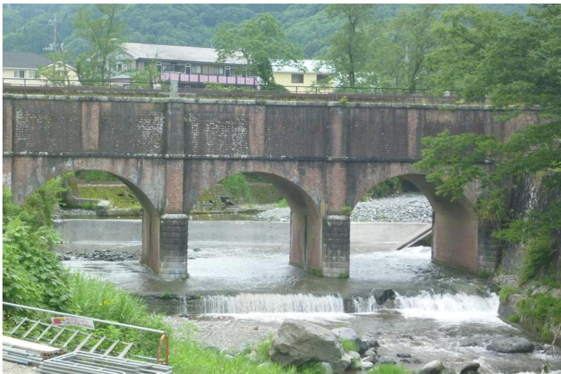
この水路橋は桂川上流の川茂発電所（都留市）から下流の駒橋発電所（大月市）に送水するために設けられた水路の一部である。
