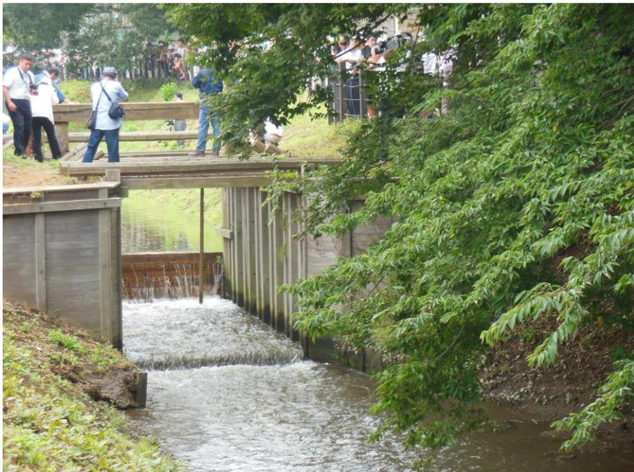
一の関（下流の閘門）に角落し（木板）を設置し、上流の水位を上げている。
