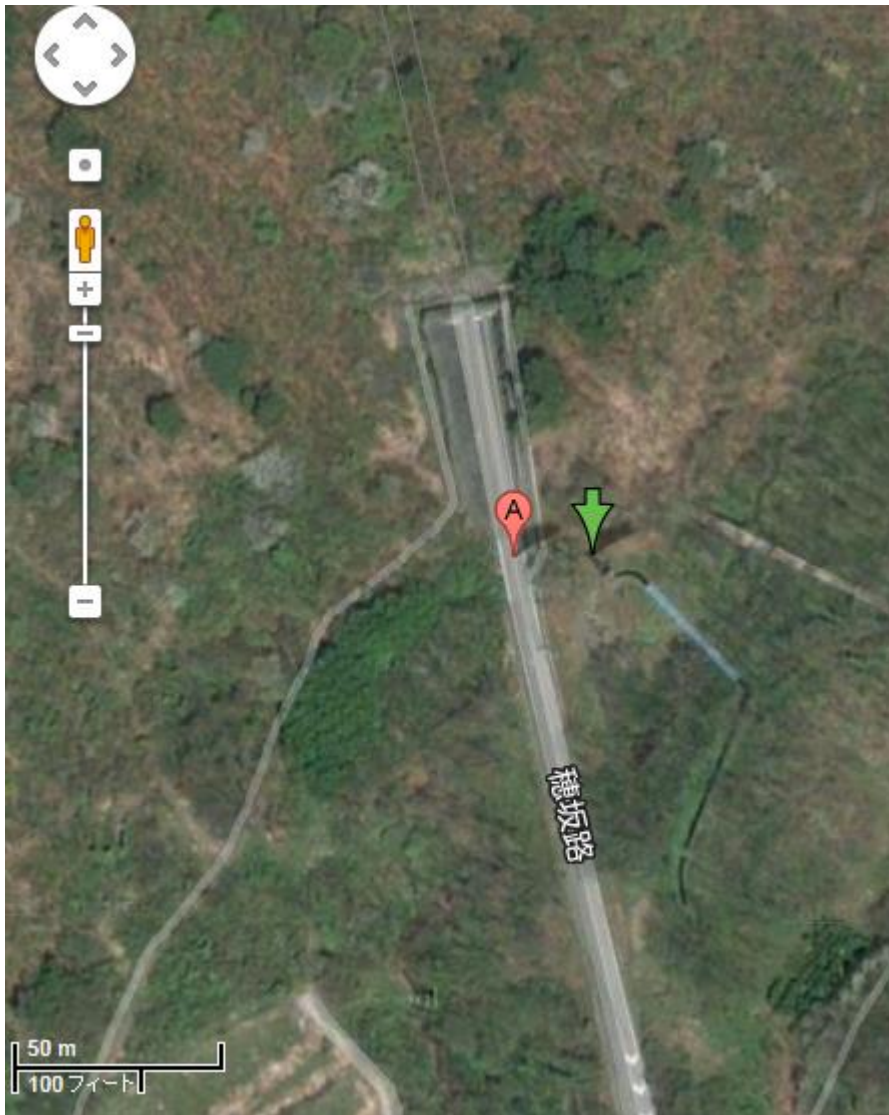
航空写真に見える水路橋と大穴隧道出口
