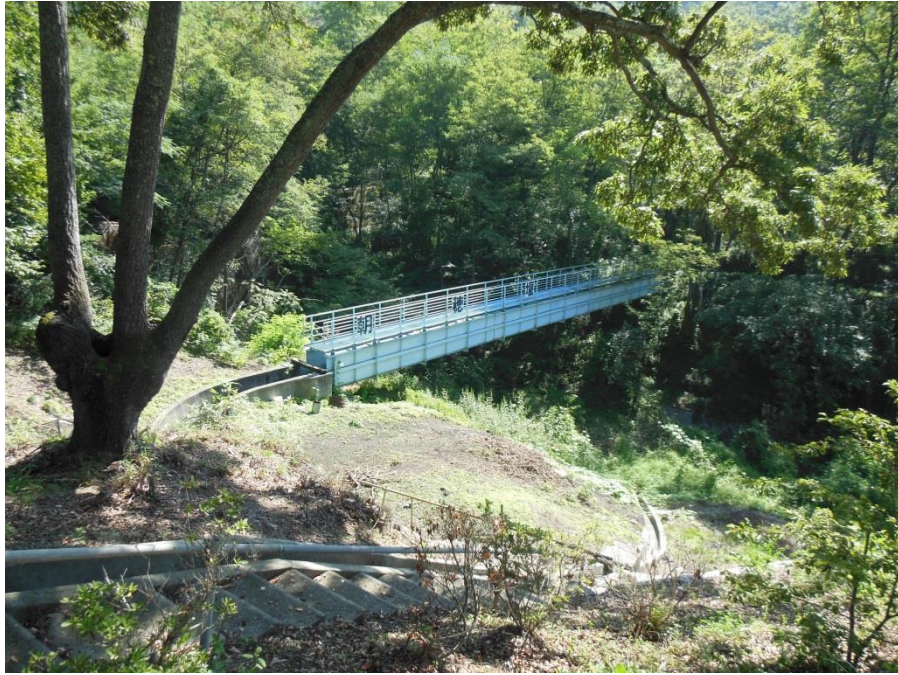
大穴隧道出口直下流の水路橋
