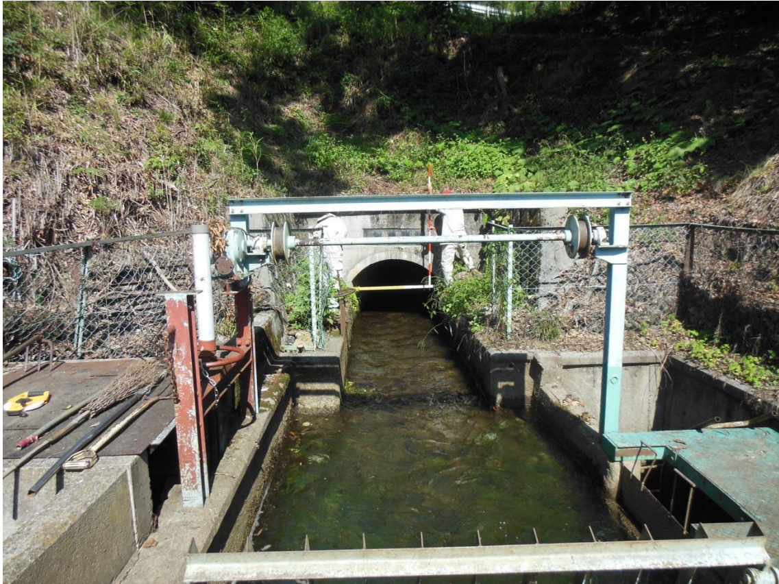
大穴隧道出口 山梨県韮崎市穂坂町三之蔵 2013年9月12日撮影
