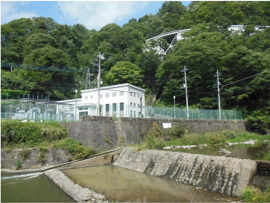
朝穂堰（用水路）の頭首工と発電所（東京電力）2013年9月13日撮影 用水は取水口からの取水と発電所からの放水を用水路に取り込んでいます。 右岸には魚道が設置されているが、流速が速く、とても魚が遡上できるとは考えにくい。
